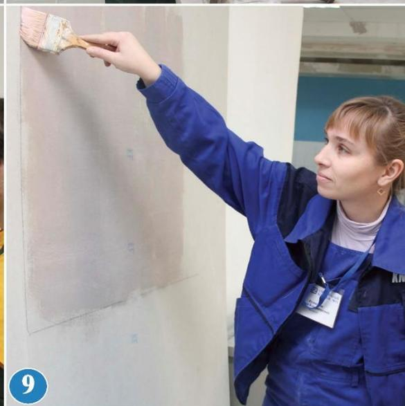
Нанесите грунтовочный состав («Бетоноконттакт») на гладкую и ровную стену, чтобы придать поверхности шероховатость и улучшить сцепление клея с поверхностью.
